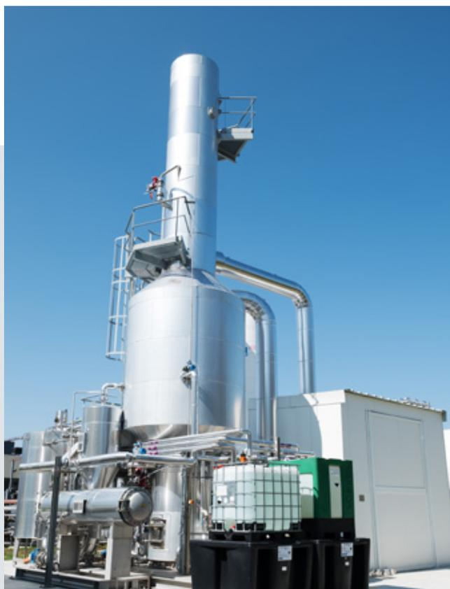
Cette installation au sein de la station d'épuration de l'usine, qui assure un traitement biologique et physico-chimique des eaux usées, permet de recycler en moyenne 200 m<sup>3</sup> d'eau par jour, soit 60 millions de litres par an ou l'équivalent de la consommation annuelle de 600 familles. Cette avancée importante en matière d'environnement est le fruit d'un travail collectif, coopératif et multi-services.
